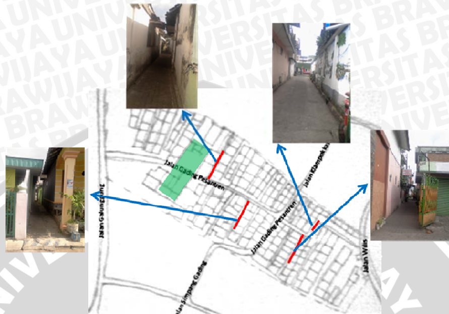
Gambar 4.37 Kondisi jalan kampung berlebar 1 meter
