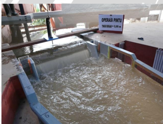
Foto 31. Kondisi Aliran pada Pelimpah
