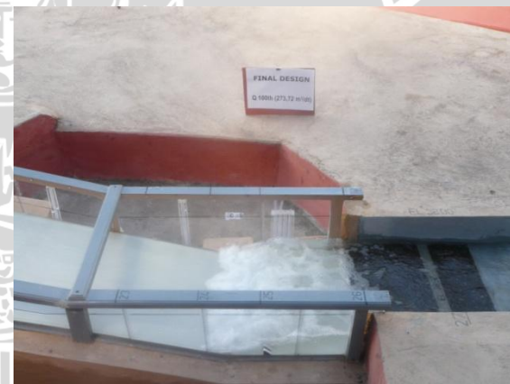
Foto 8. Kondisi Aliran pada Stilling Basin
