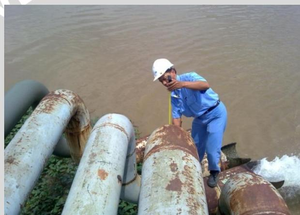
Pengukuran Ketinggian Pipa Pembuangan Apabila Dilakukan Pemotongan
