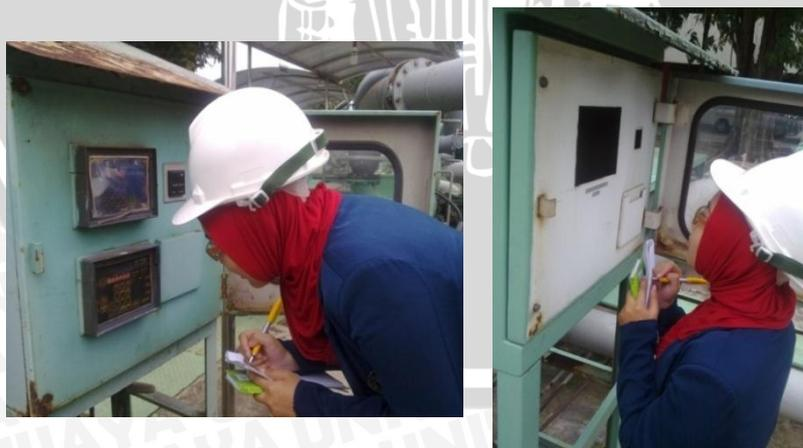
Pengecekan Volume Air dan Debit Air Buangan pada Flowmeter
