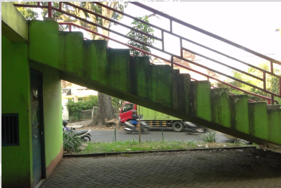
Gambar 4.16 Dinding di sisi Jl. Tangkuban Perahu
