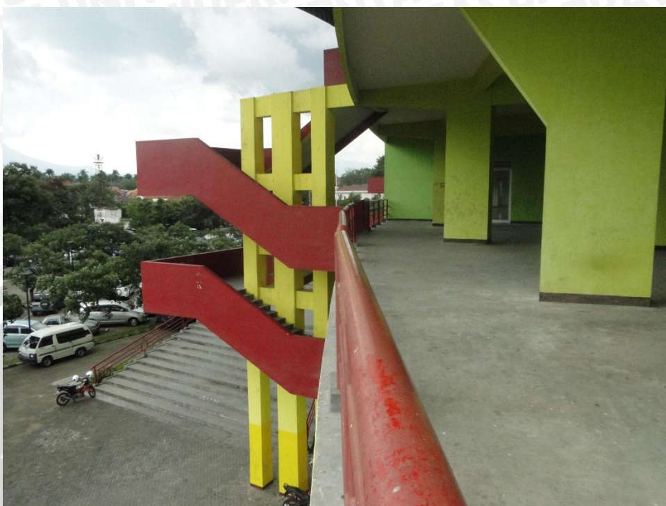
Gambar 4.5 Tangga Sebelah Selatan Menuju Pintu VIP
