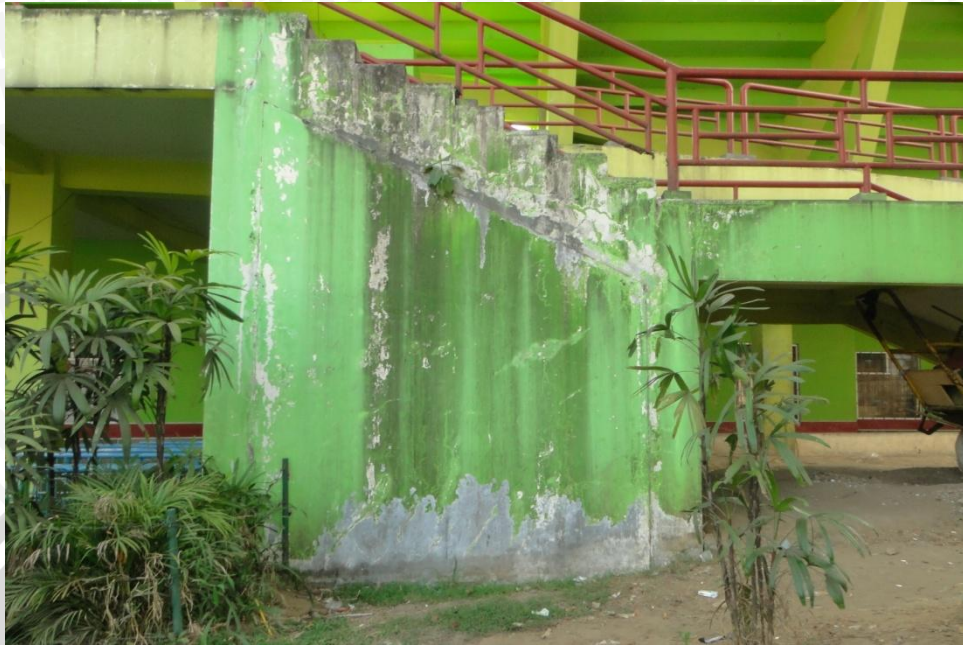
Gambar 4.15 Dinding di sisi Jl. Tangkuban Perahu
