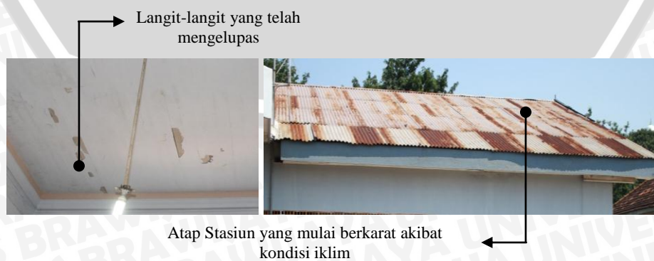
Gambar 4.76 Perubahan pasif pada langit-langit dan penutup atap bangunan Stasiun Kereta Api Probolinggo
