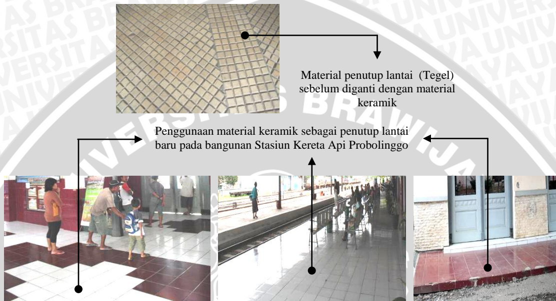
Gambar 4.75 Pergantian penutup lantai pada bangunan Stasiun Kereta Api Probolinggo
