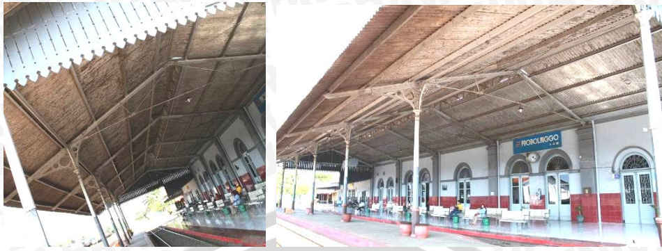
Gambar 4.72 Konstruksi atap ruang tunggu bangunan Stasiun Kereta Api Probolinggo
