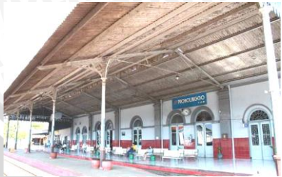
Atap ruang tunggu berbentuk atap pelana dengan konstruksi rangka baja
