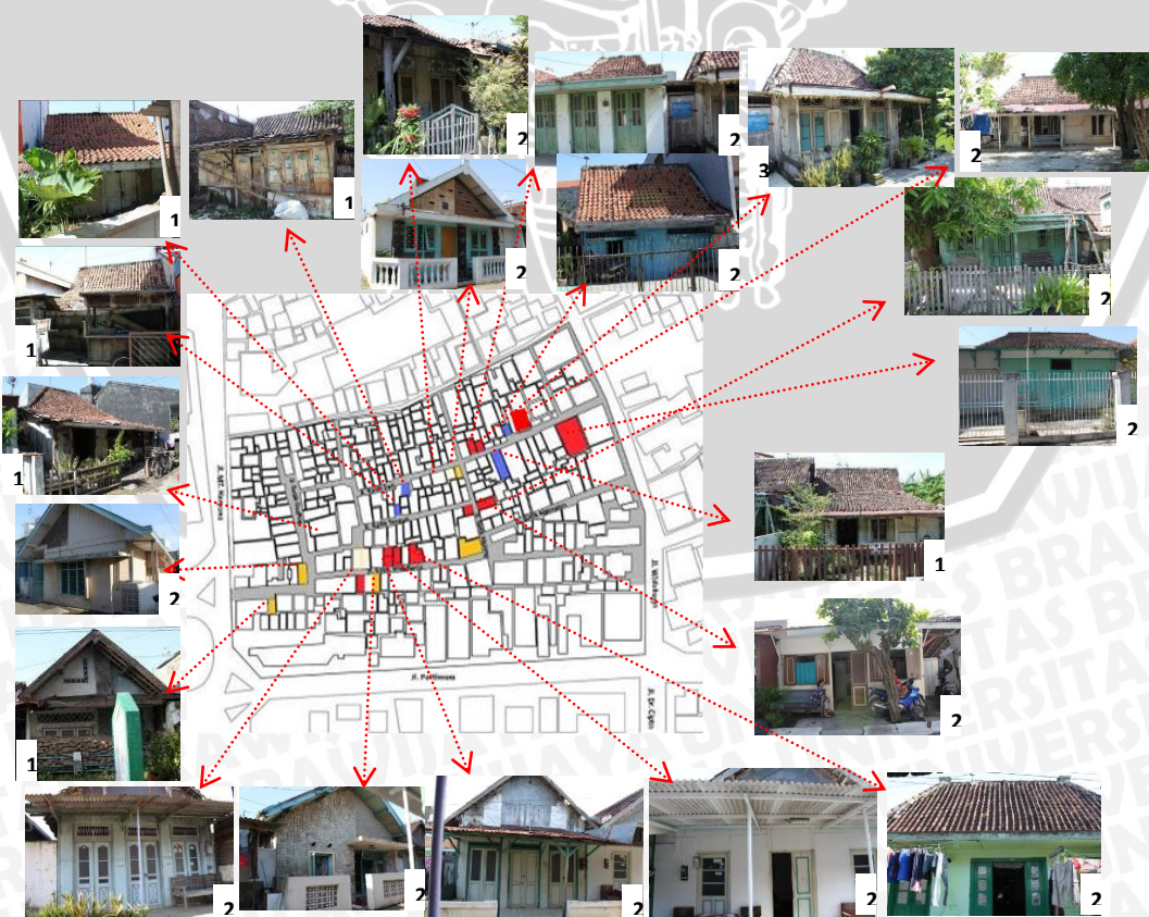
Gambar 4.72 Peta persebaran bangunan lama
