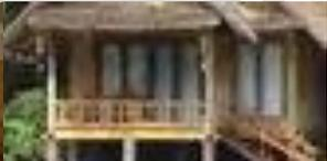
Pemaksimalan udara yang masuk melalui bukaan jendela hidup dengan orientasi ke arah danau dan celah dari gedheg (anyaman bambu pada dinding). |
