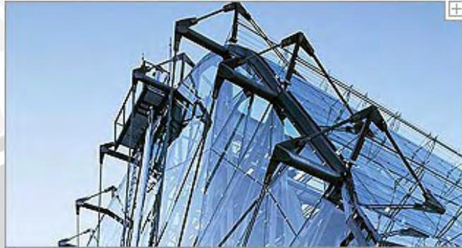
Gambar 2.26. Sistem struktur space truss pada bangunan dengan menggunakan baja.
