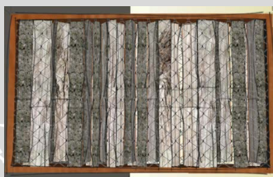
Gambar 4.8j Limbah potongan kayu galam sebagai cladding .
