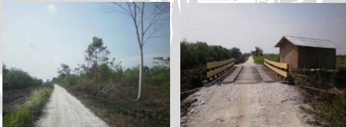
Gambar 4.4.2a Kondisi jalan poros (utama) di UPT Simpang Arja, Barito Kuala, Kalimantan Selatan.
