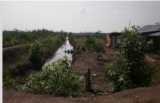
Gambar 4.4.2e Saluran tersier lebar 2 meter.
