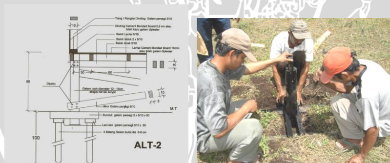
Gambar 2.5c Pemasangan kayu galam sebagai pondasi.
