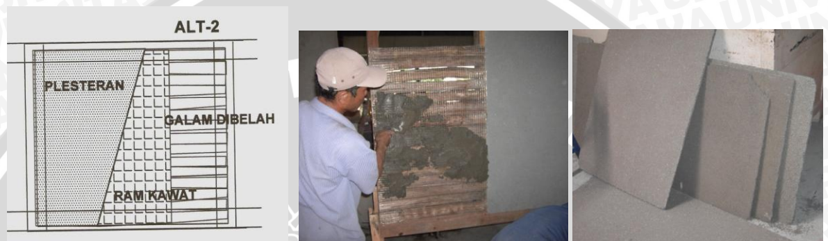
Gambar 2.5d Kayu galam sebagai dinding.
