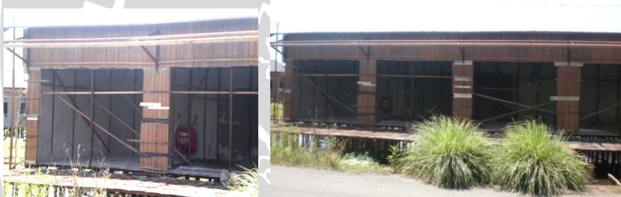
Gambar 2.5k Lampit rotan sebagai penutup dinding.
