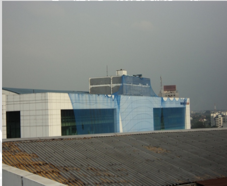
Gambar 4.2 Gedung lokasi BTS yang lama Sumber : foto pribadi
