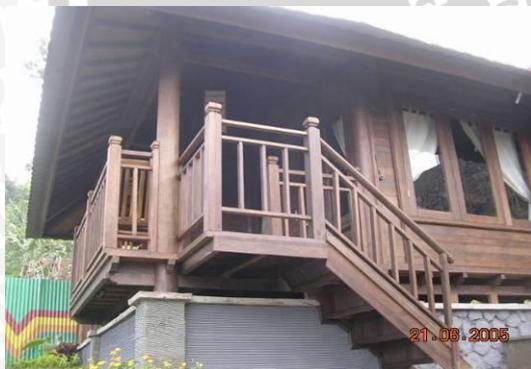
Gambar 2.5. Penerapan Glugu Pada Teras Bangunan
