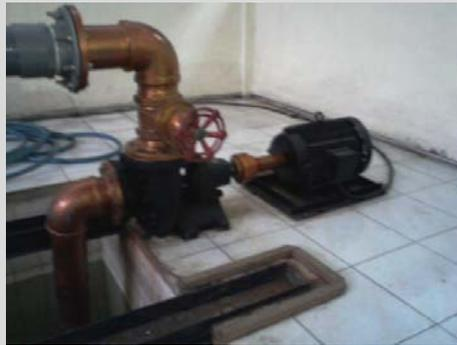
Gambar 3.1 : Pompa Sentrifugal
