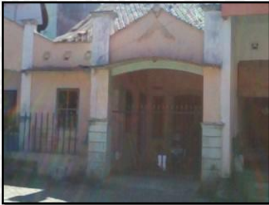
Gambar 2 Kondisi Rumah di Perumahan Sederhana
