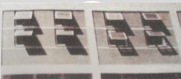
Gambar 2.8 Jendela Dengan Bukaan Horizontal Dalam Keadaan Terbuka Berfungsi Sebagai Pelindung Terhadap Kesilauan Angkasa sumber: Mangunwijaya (2000)
