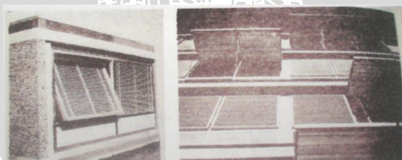
Gambar 2.9 Contoh Pemasangan Kisi – Kisi yang Salah (kiri) dan Benar (kanan) sumber: Mangunwijaya (2000)
