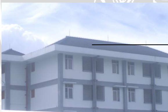
Gambarl 4.13 Atap Perisai Pada Bangunan sumber : Data Olahan pribadi
