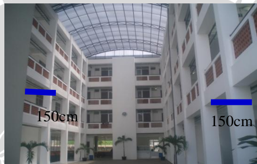
Gambarl 4.5 Teritisan Selatan dan Utara (sisi dalam) sumber : Data Olahan pribadi
