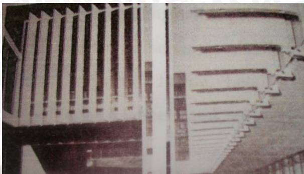
Gambar 2.7 Konstruksi Jalusi Yang Dipasang Berporos Vertikal Dan Dapat Disetel Sudut Kedudukannya sumber: Mangunwijaya (2000)
