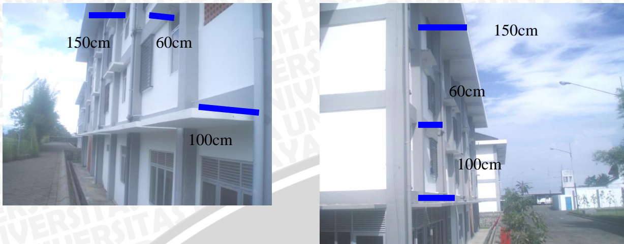
Gambarl 4.4 Teritisan Selatan dan Utara Bangunan sumber : Data Olahan pribadi
