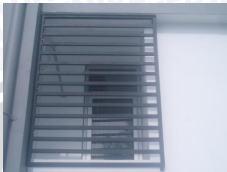
Gambar 4.17 Jendela Dengan Penggunaan Loggia dan Ditutup Teralis sumber : Data Olahan pribadi
