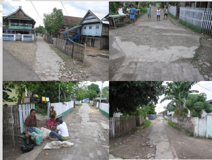
Gambar 4.64 Kondisi Jalan yang mengalami kerusakan
