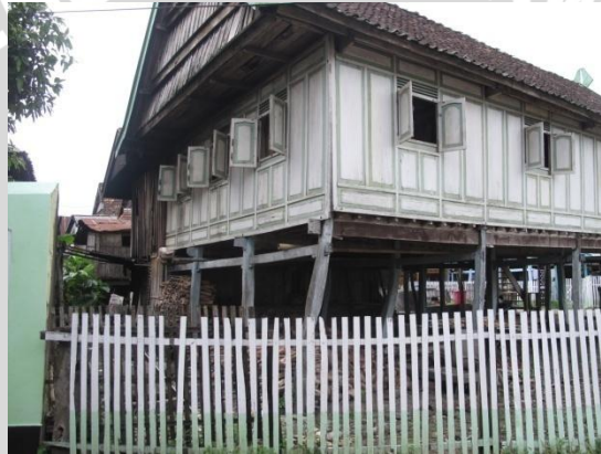
Gambar 4.47 Penggunaan Area Kolong sebagai tempat penyimpanan
