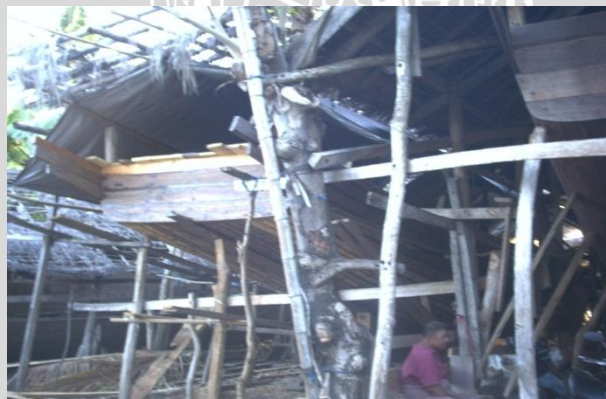
Gambar 4.38. Area Pengerjaan Lokasi B
