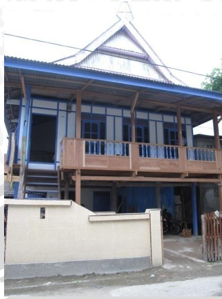
Gambar 4.49. Penggunaan Warna Cat yang sama untuk menutupi perbedaan material
