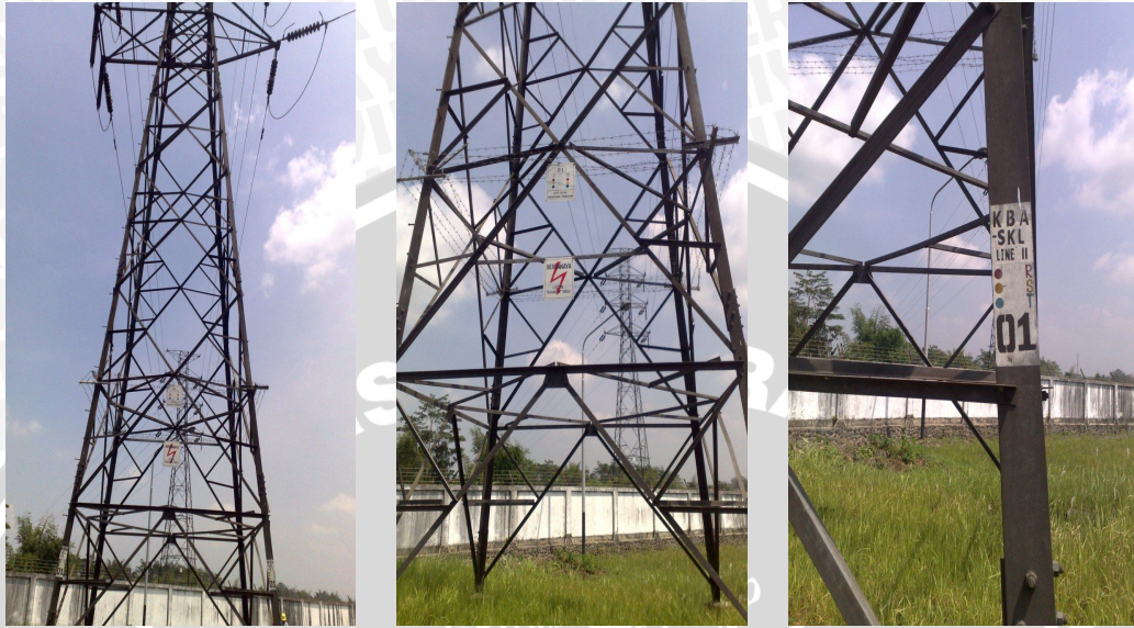
Gambar L.3.1 Kontruksi Tower Tiang 1 GI Sengkaling – GI Kebonagung
