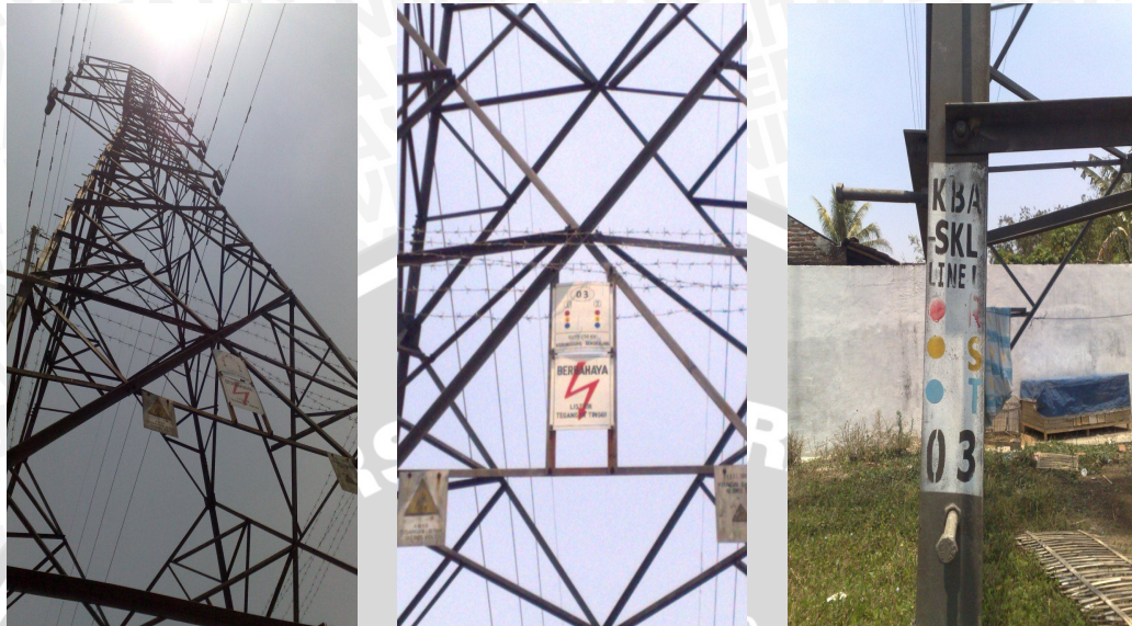
Gambar L.5.1 Kontruksi Tower Tiang 3 GI Sengkaling – GI Kebonagung
