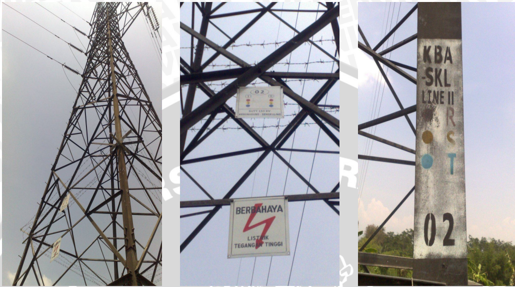
Gambar L.4.1 Kontruksi Tower Tiang 2 GI Sengkaling – GI Kebonagung
