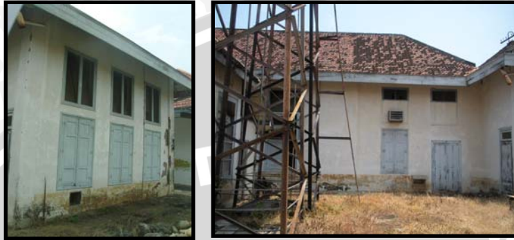
Gambar 4.133. Dinding bangunan DPPL
