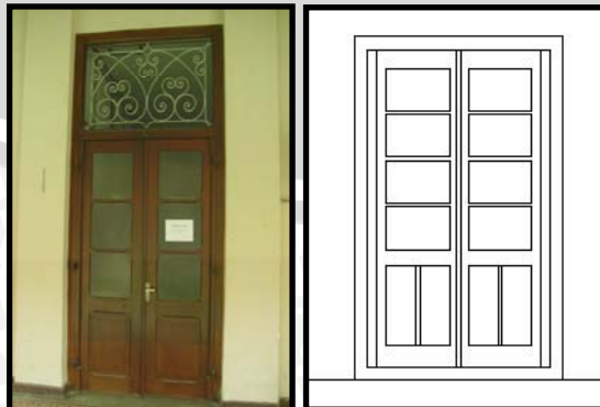
Gambar 4.115. Pintu bangunan PHP
