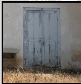
Gambar 4.82. Pintu bangunan DPPL
