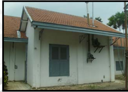
Gambar 4.136. Dinding bangunan Gudang
