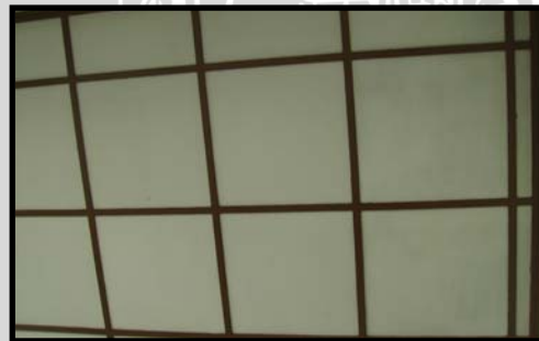
Gambar 4.85. Jendela bangunan DPPL
