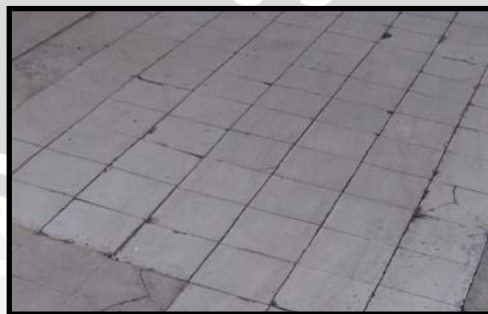
Gambar 4.75. Lantai pada bangunan engineering
