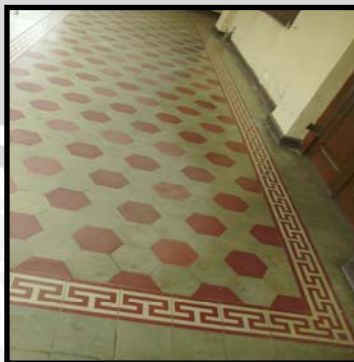
Gambar 4.36. Lantai di bangunan PHP
