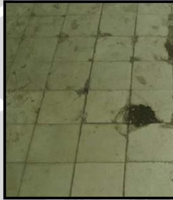
Gambar 4.84. Lantai bangunan DPPL
