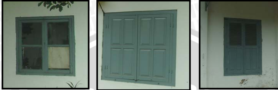
Gambar 4.138. Jendela bangunan Gudang
