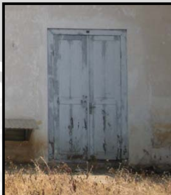
Gambar 4.134. Pintu bangunan DPPL
