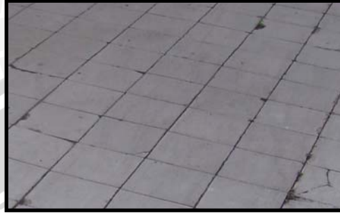
Gambar 4.93. Lantai bangunan Gudang
