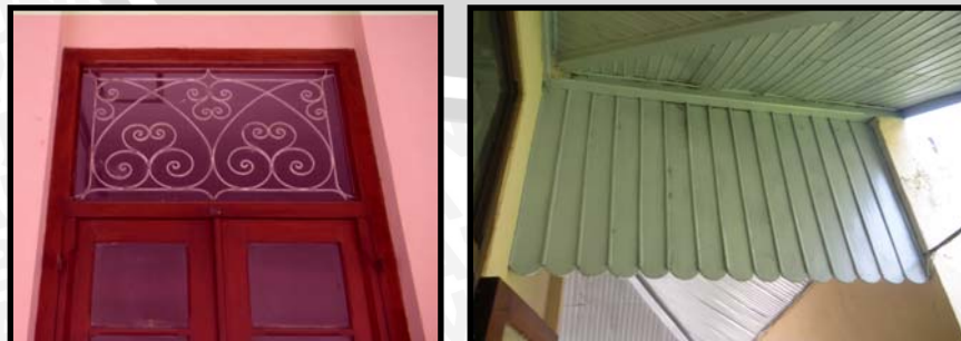
Gambar 4.117. Ornamen bangunan PHP
