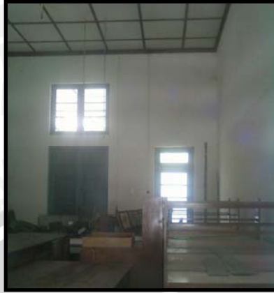
Gambar 4.86. Dinding bangunan DPPL
