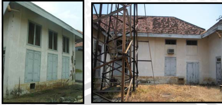
Gambar 4.81. Dinding bangunan DPPL
