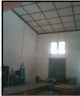
Gambar 4.95. Dinding bangunan Gudang
