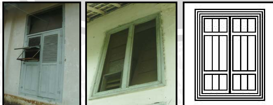
Gambar 4.83. Jendela bangunan DPPL
