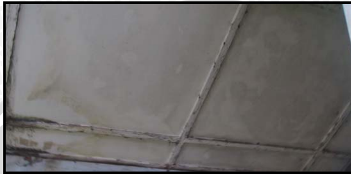
Gambar 4.76. Plafond pada bangunan engineering
