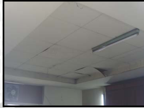
Gambar 4.27. Plafond interior pengadaan
