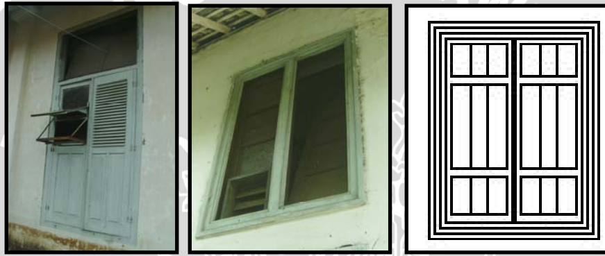
Gambar 4.135. Jendela bangunan DPPL
