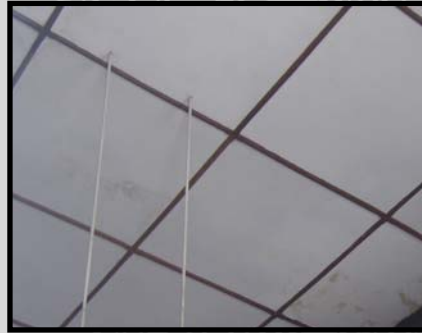
Gambar 4.94. Plafond bangunan Gudang
