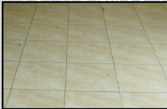
Gambar 4.64. Lantai lab kimia tanah
