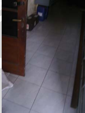
Gambar 4.45. Lantai di Laboratorium Bibit
