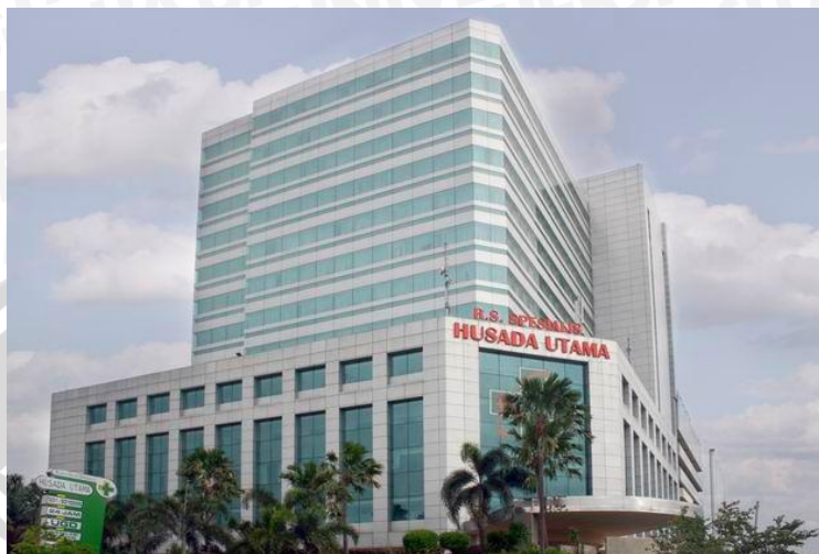
Gbr. 4.20. Fasade Bangunan Rumah Sakit Husada Utama Sumber: Dokumentasi Pribadi
