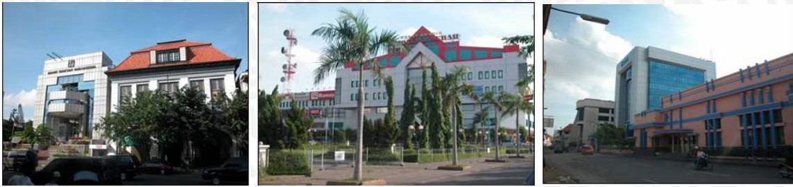
Gbr. 4.21. Bangunan-bangunan di Jl. Rajawali Surabaya Sumber: Dokumentasi Pribadi
