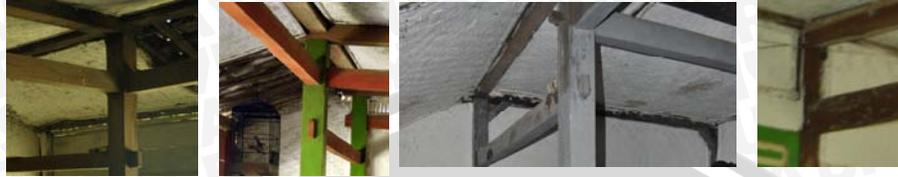
Gambar 4.52. bahan struktur kayu nangka
