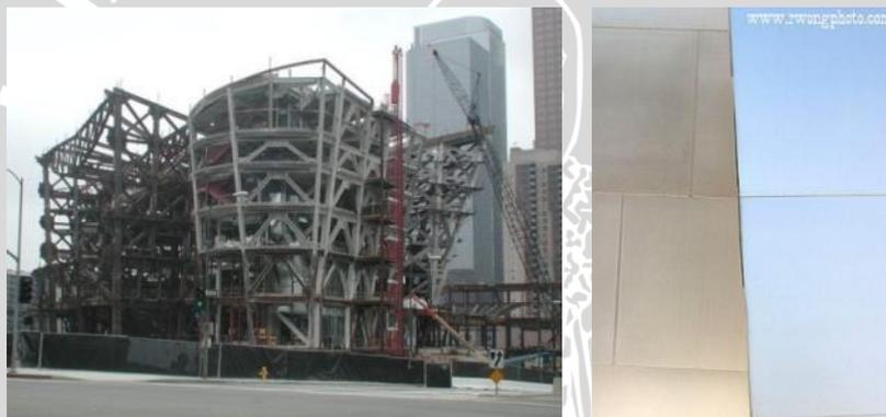
Gambar 4.67 Struktur dan detail selubung bangunan
