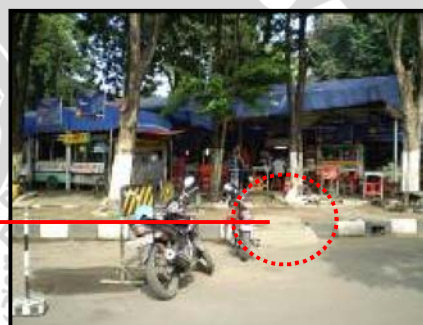
Gambar 4.86. Material Plesteran Semen pada Beberapa Tempat di Area Warung Tenda Sumber : Dokumentasi Pribadi, 2010
