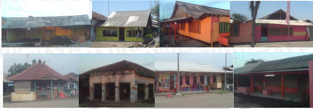
Gambar 4.60 Tipe bentuk bangunan pada pantai Blimbingsari
