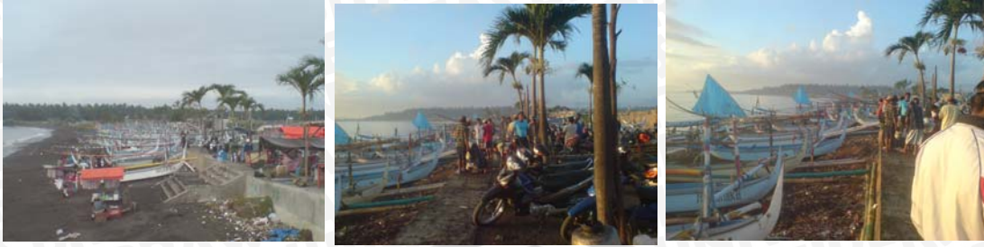
Gambar. 4.26 Kondisi eksisting area sandar perahu nelayan
