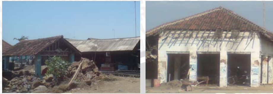
Gambar. 4.19 Kondisi eksisting bangunan pelelangan ikan
