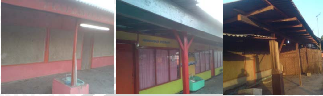
Gambar. 4.16 Kondisi eksisting material dinding bangunan
