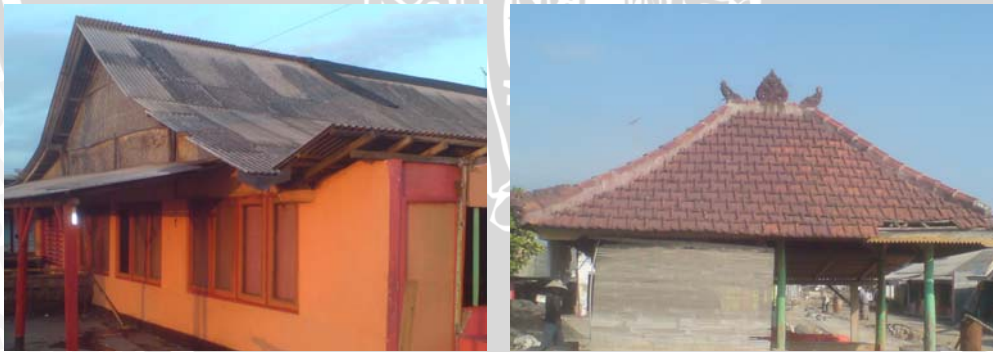
Gambar. 4.18 Kondisi eksisting material Penutup atap
