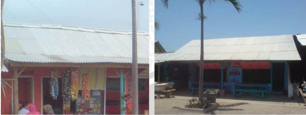
Gambar. 4.23 Kondisi eksisting material penutup atap asbes
