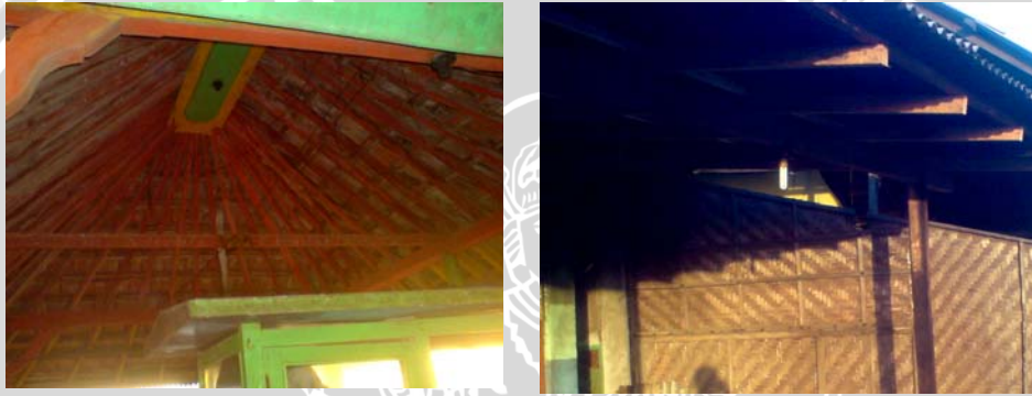
Gambar. 4.17 Kondisi eksisting material rangka atap bangunan
