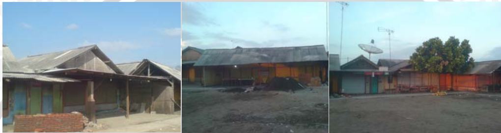
Gambar. 4.13 Kondisi eksisting cluster 1 bagian selatan
