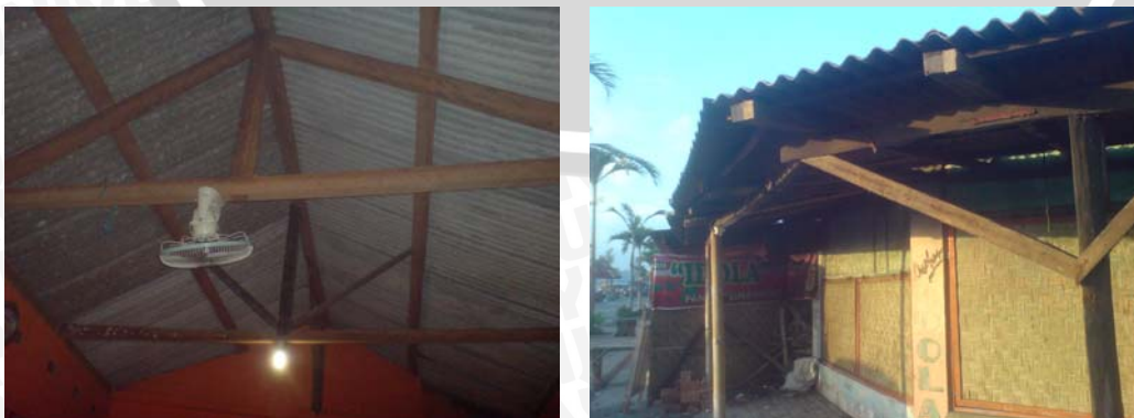
Gambar. 4.22 Kondisi eksisting material kayu sebagai rangka atap
