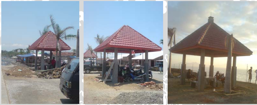
Gambar. 4.29 Kondisi eksisting gazebo
