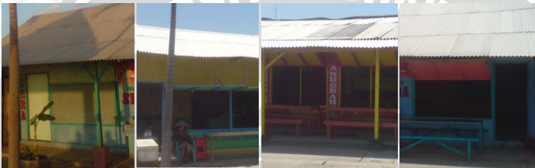
Gambar. 4.24 Kondisi eksisting material penyusun dinding
