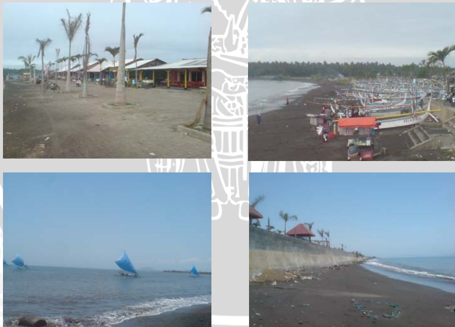
Gambar. 4.10 Kondisi eksisting pantai dan bangunan sekitarnya
