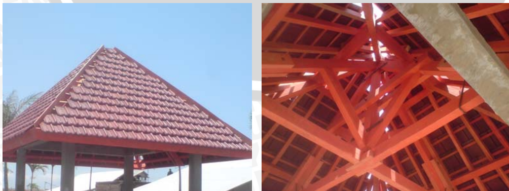
Gambar. 4.30 Kondisi eksisting konstruksi penutup atap dan rangka atap gazebo
