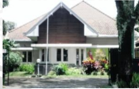
Gambar 4. 62 Bangunan dengan perubahan fungsi yaitu rumah yang diubah fungsinya menjadi butik.
