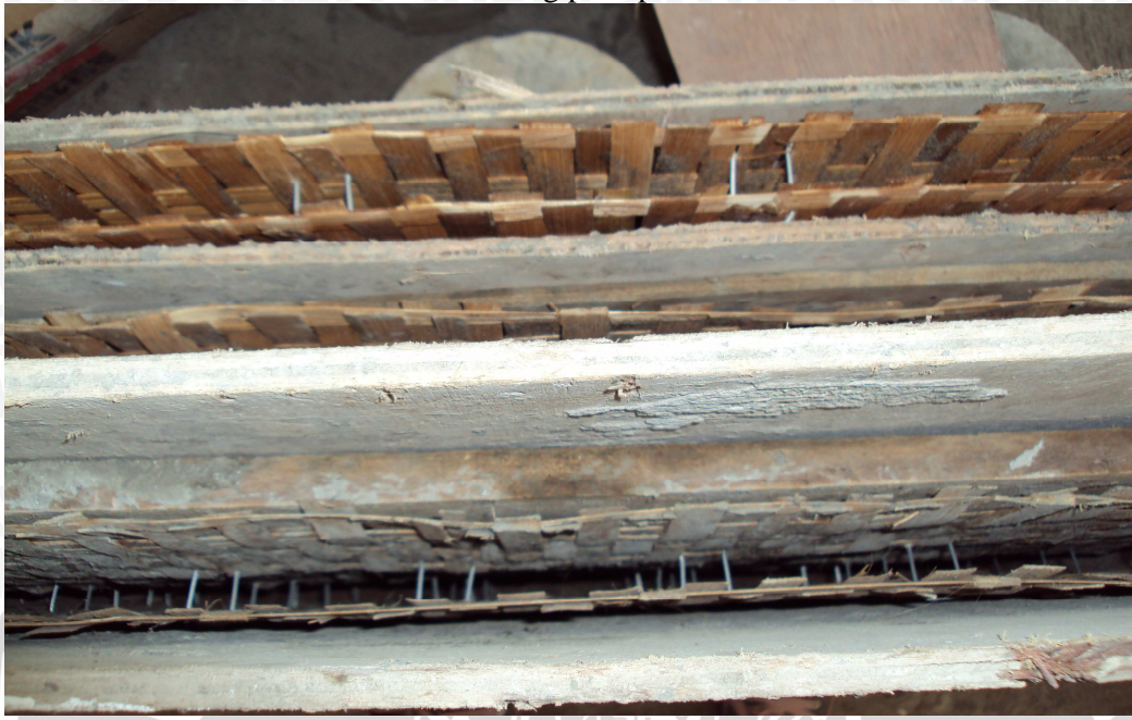
LAMPIRAN 11 Bekisting pada panel
