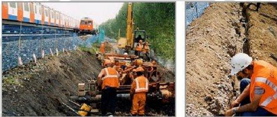
Gambar 2.13 Pemasangan Elektroda Elektrokinetik Pada Kereta Api Tanggul
