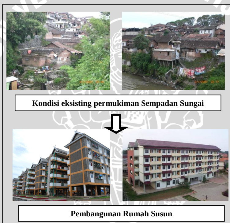
Gambar 4.67 Pembangunan Rumah Susun Untuk Warga Yang Direlokasi
