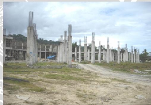
**Gambar 4.10** Pembangunan tiang-tiang pancang, balok-balok beton
