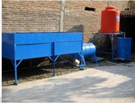
**Gambar 4. 40 Pilot project Instalasi Pengolah Air Limbah (IPAL) Untuk Mendaur Ulang Air Limbah Batik Yang Menggunakan Teknik Biologi Laguna Aerob Di Pekalongan**
