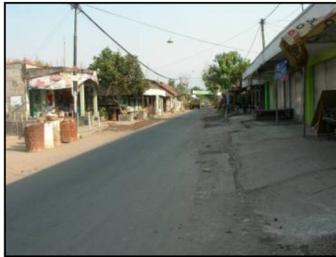
Gambar 4. 13 Jaringan listrik yang telah terpasang di ruas jalan Desa Sidomulyo
