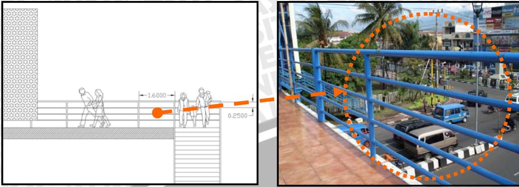
**Gambar 4.44.** Railing pada jembatan penyeberangan di jalan Ahmad Yani
