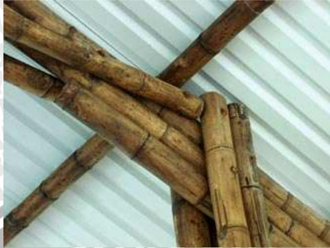
**Gambar 50.** Koneksi truss dengan baut
