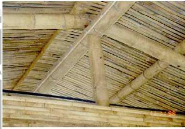
**Gambar 65.** Konstruksi bambu setelah 12 tahun
