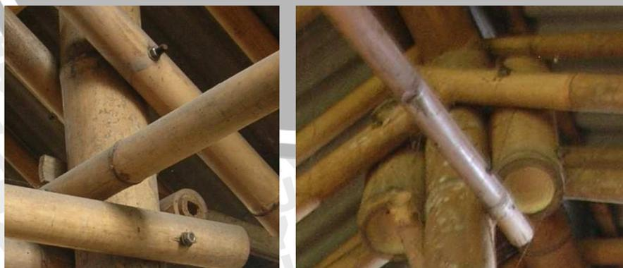
**Gambar 61.** Pengikat dengan baut Ø 12 mm
