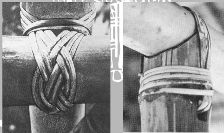
**Gambar 81.** Sambungan dengan kulit rotan
