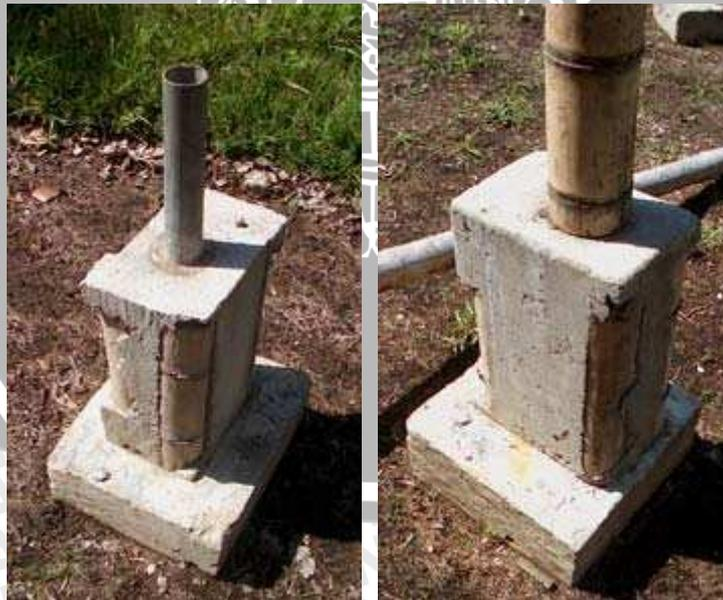
**Gambar 55.** Pondasi menggunakan 1 batang kolom dengan penambahan pipa didalamnya
