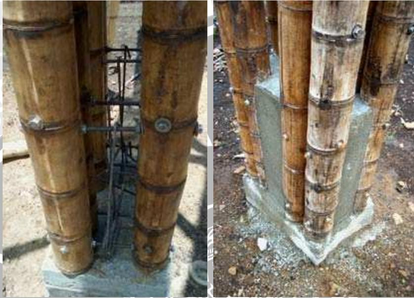
**Gambar 56.** Pondasi menggunakan 4 batang kolom atau lebih
