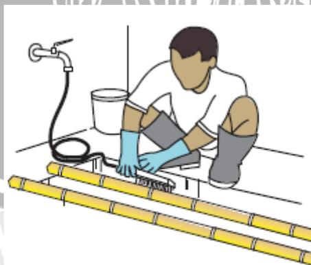
**Gambar 27.** Pembersihan batang bambu
