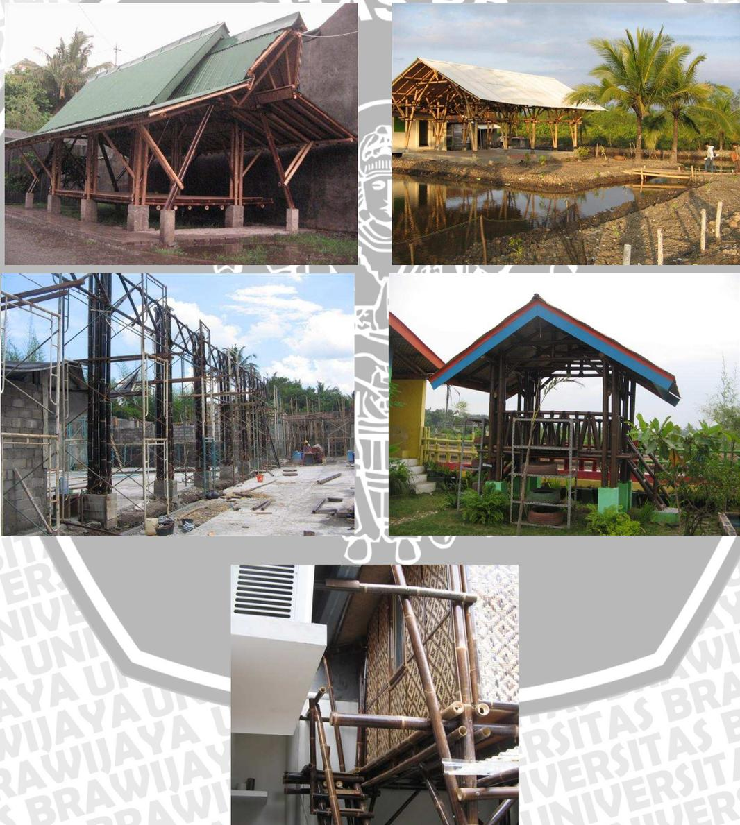
**Gambar 1.** Contoh bangunan menggunakan konstruksi bambu.
