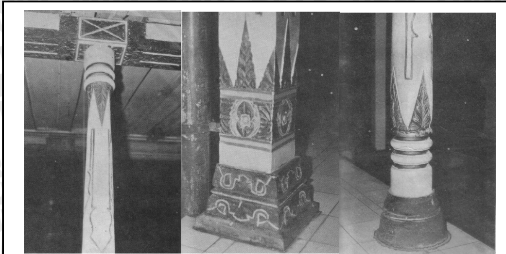
Gambar 2.25 Ornamen ukir kayu tradisional pada kolom-kolom Masjid Agung Yogyakarta . Sumber: Wiryoprawiro, 1986
