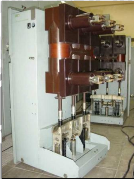
Gambar 2.5 PMT 20kV yang Dikeluarkan dari Cubicle Sumber: PT PLN (Persero) Jasa Pendidikan dan Pelatihan
