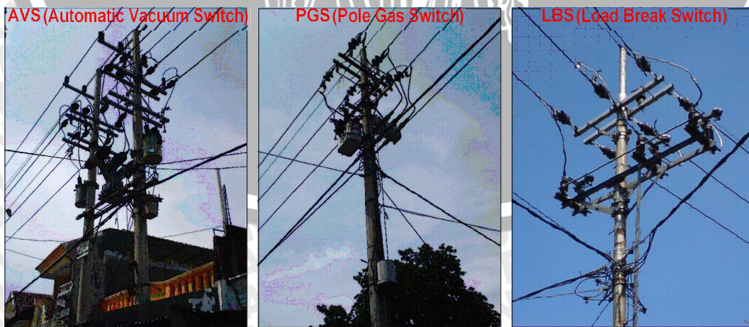
Gambar 2.8 Sectionalizer tipe AVS, PGS, dan LBS (manual)
