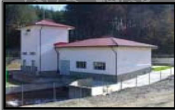
Gambar 1.1 Bentuk Gedung Sentral PLTM
