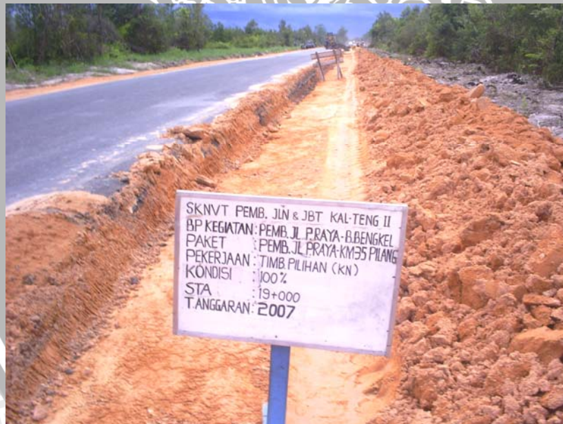
Gambar 4.21 Timbunan pilihan
