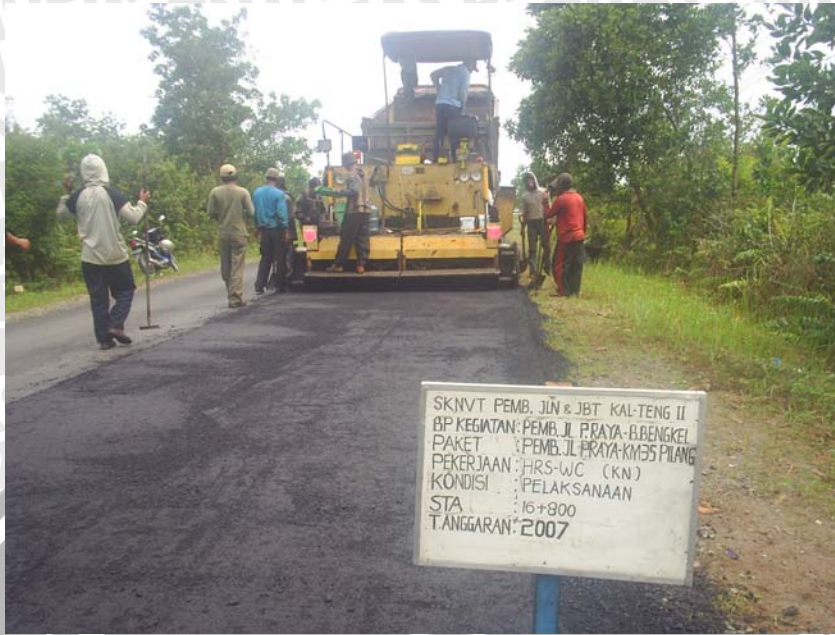
Gambar 4.18 Tahap overlay HRS-WC
