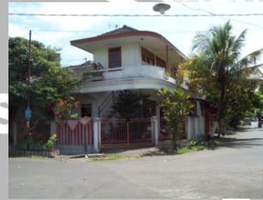
Gambar 4.30. Perumahan Griya Shanta (D)
