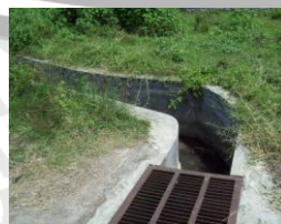
Gambar 4.47. Saluran drainase di sepanjang perumahan Griya Shanta (B)
