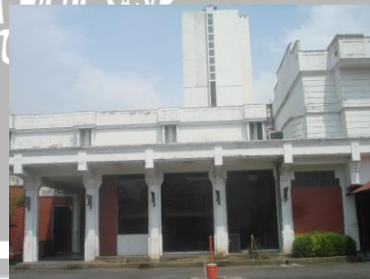
Gambar 1.5 Distorsi Visual pada Komposisi Bangunan
