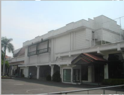
Gambar 1.2 Gedung Bioskop Mitra
