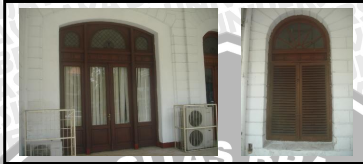
Gambar 4.27 Bentuk Pintu dan Jendela pada Gedung Balai Pemuda dengan Konstruksi Vursoir
