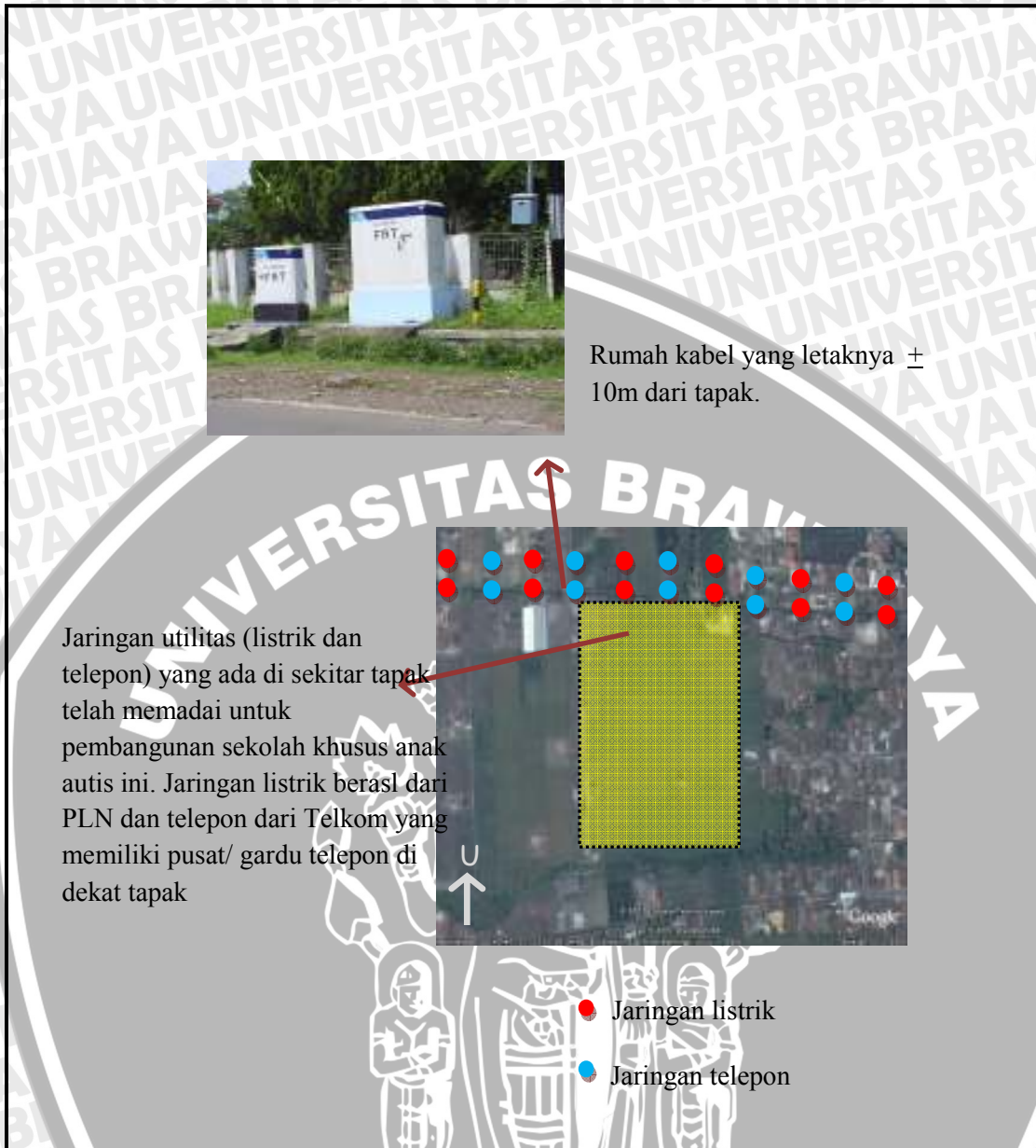
Gambar 4.9 Kondisi jaringan utilitas pada tapak
