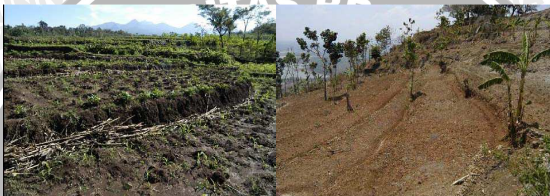
Gambar 4.13 Teras yang kurang terpelihara dan teras yang tidak terpelihara.
