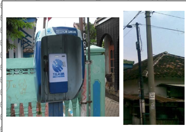
Gambar 4. 37 Kondisi jaringan telepon di wilayah permukiman Kelurahan Panggungrejo
