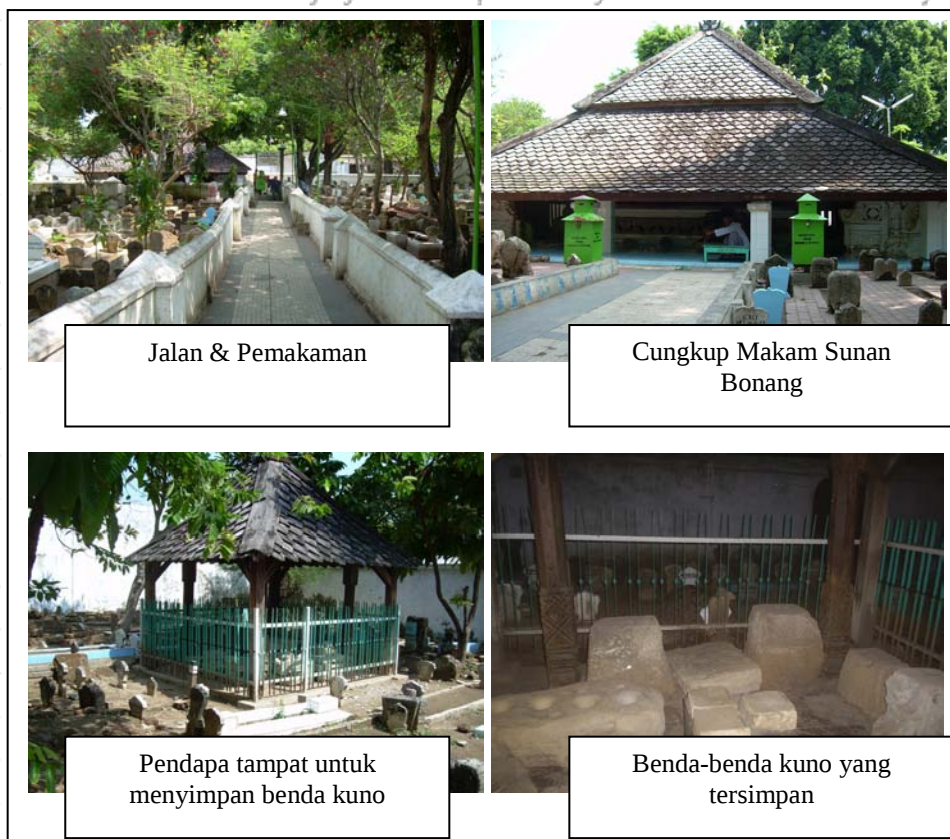
Gambar 4.17 Bangunan dan lingkungan di Komplek Makam Sunan Bonang
