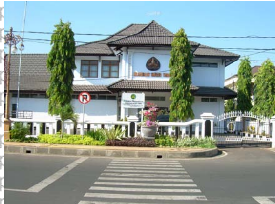
Nama : Kantor Bappeda Kab. Tuban Fungsi baru : Kantor Tahun Berdiri : 1978 Gaya arsitektur : Kolonial-Modern
