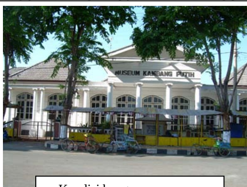
Kondisi bangunan museum
