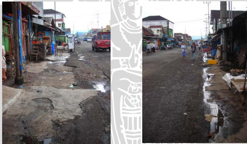
Gambar 4.2. Kondisi sisi jalan yang telah terbangun
