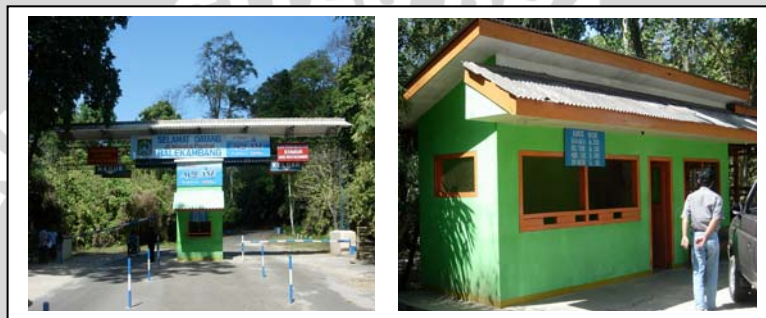
Gambar 4.27 Kondisi Loket Masuk Kawasan Wisata Pantai Balekambang
