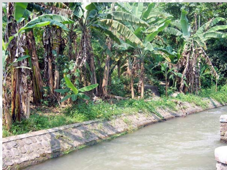
Gambar Saluran Pembawa Pembangkit PLTMH
