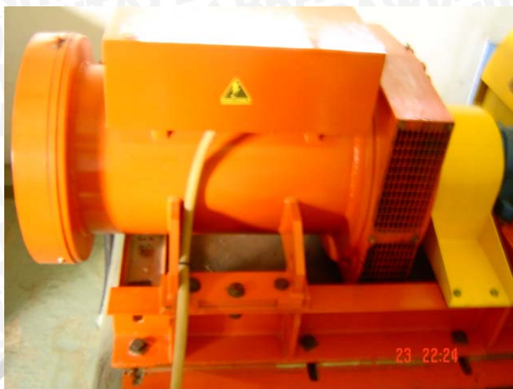
Gambar Generator 40 Kva PLTMH Kalimaron
