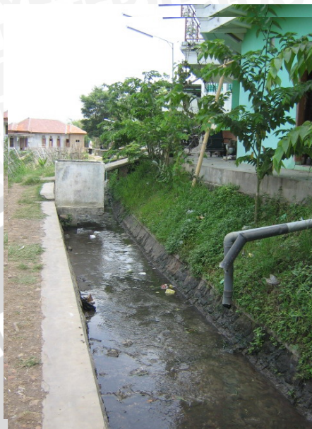
Gambar 4.10 Saluran Drainase Sekunder
