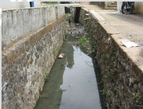
Gambar 4.9 Saluran Drainase Permukiman
