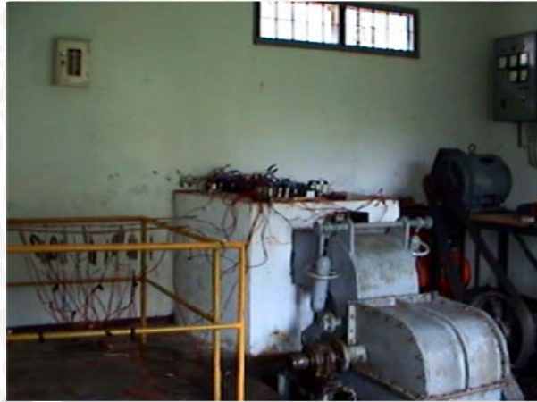
Gambar L-7.7. Pengujian pengoperasian mesin induksi 22 kW sebagai generator induksi beroperasi sendiri
