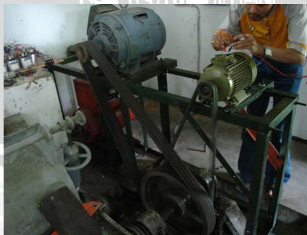
Gambar L-7.3. Penempatan generator induksi 22 kW dan 3 kW pada PLTM Check Dam V Kali Jari
